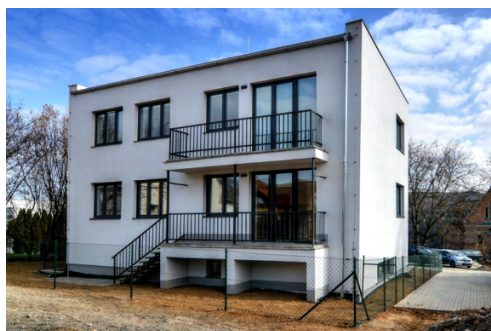
Novostavba se 3 byty, Bílovice n. Svitavou
