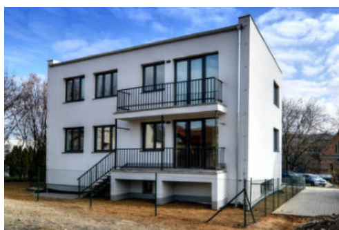
Novostavba se 3 byty, Bílovice n. Svitavou
