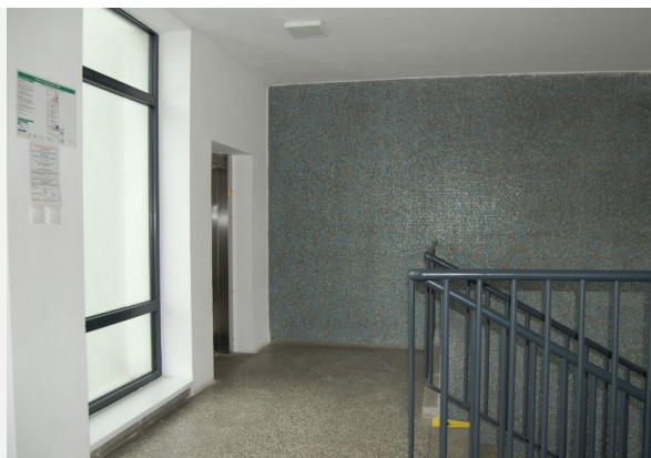
Chodba se schodištěm a výtahem
