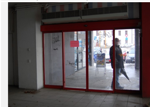
Vchod do objektu ze severní strany 1.NP – bývalá prodejna potravin
