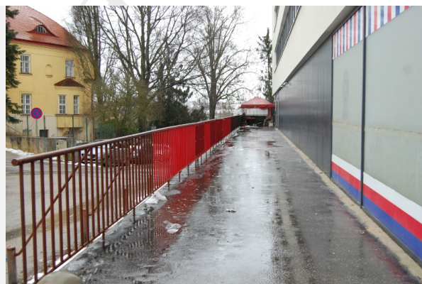
Východní stranu objektu
