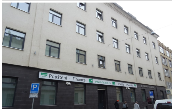
Pohled z ulice Bratislavská (Budova A)
