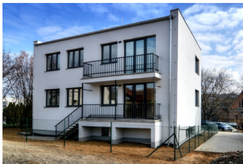
Novostavba se 3 byty, Bílovice n. Svitavou
