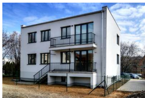
Novostavba se 3 byty, Bílovice n. Svitavou
