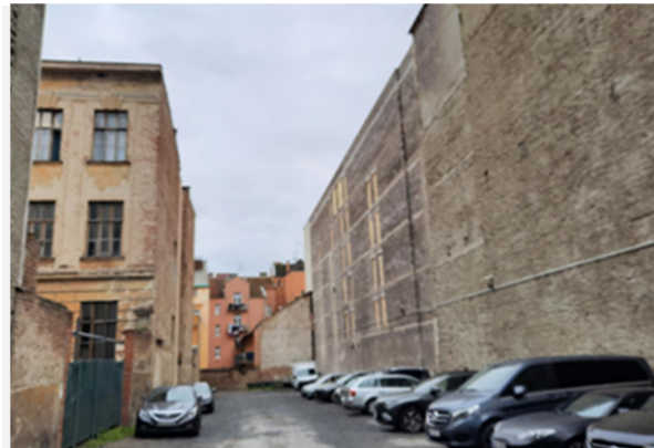
Pohled celkový do proluky – provizorní parkovací stání
