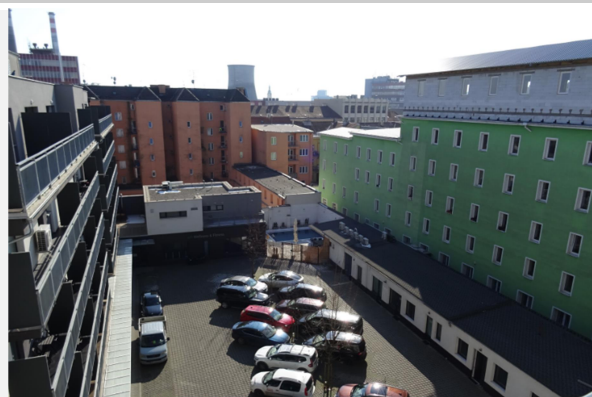
Pohled do dvora – parkovací stání + západní část
