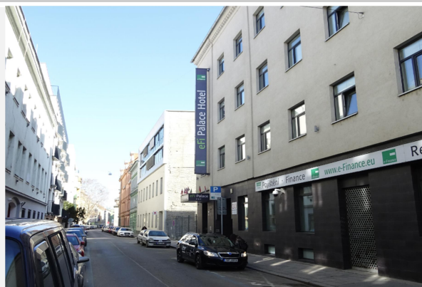
Pohled z ulice Bratislavská (BUDOVA A)
