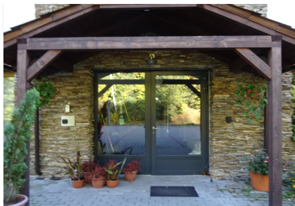
Pohled na hlavní vchod (z JZ strany)
