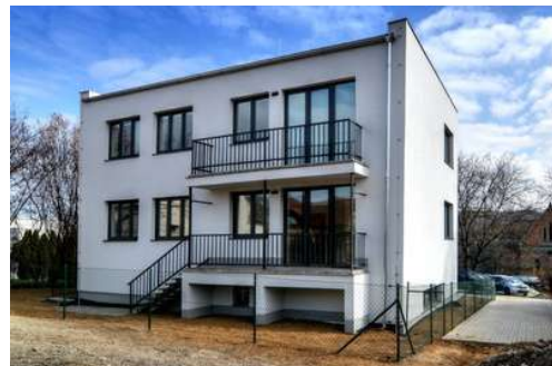
Novostavba se 3 byty, Bílovice n. Svitavou
