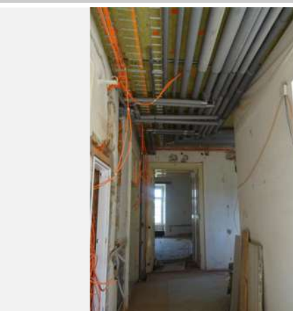
3.NP opravy rozvodů
