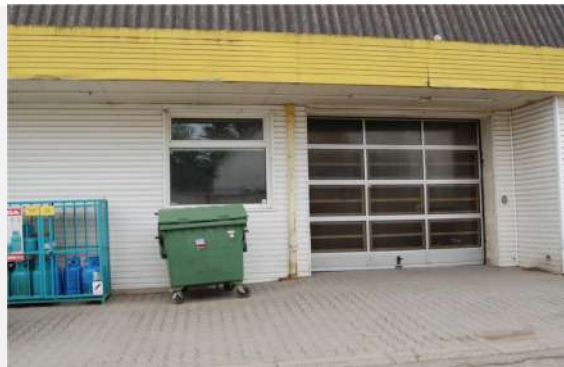
Pohled na vjezd do dílny z ul. Farní
