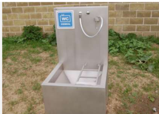
Pohled na likvidační zařízení fekálií
