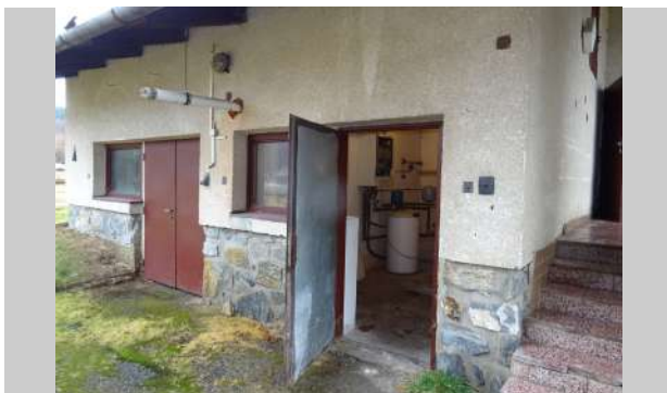
Sklad a technická místnost
