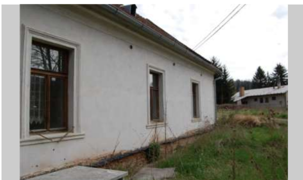
Pohled na mlýn z jižní strany
