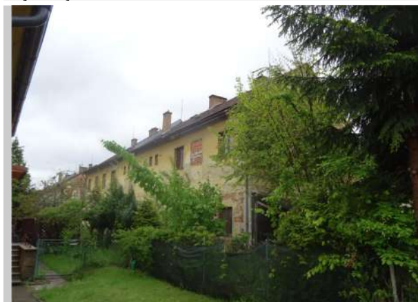
Bytový dům ze strany rodinných domů
