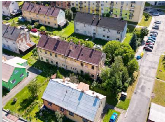
Pohled na bytový dům z východní strany
