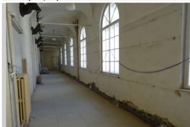
2.NP probíhající opravy zdroj: vlastní
