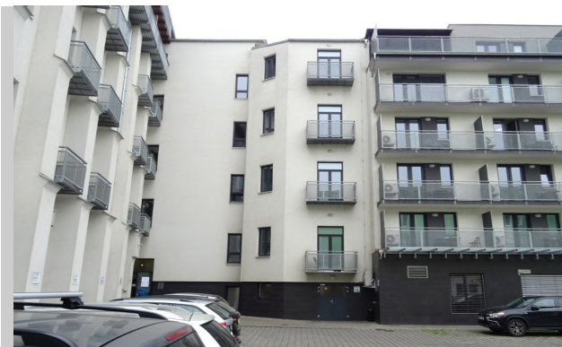
Pohled na východní část (Budova B)
