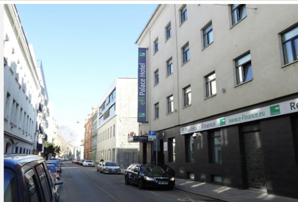
Pohled z ulice Bratislavská (Budova A)
