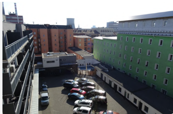
Pohled do dvora – parkovací stání + západní část
