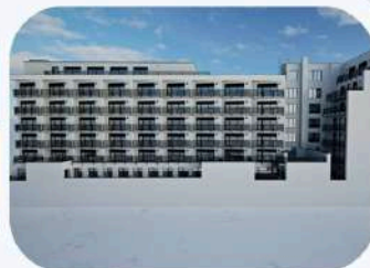
Přístavba EFI Palace, Brno
