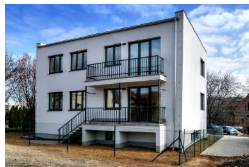
Novostavba se 3 byty, Bílovice n. Svitavou
