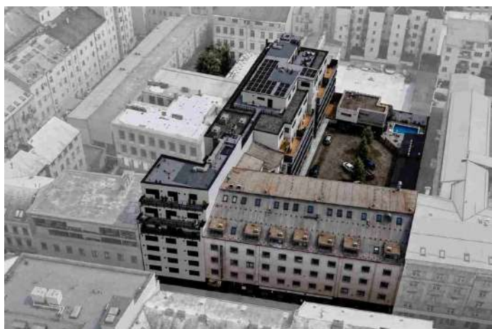
Brno, EFI Palace - 3. etapa - severní pohled
