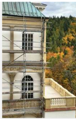
Provedené opravy balkónů a balustrád
