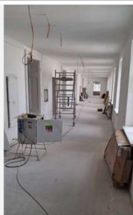
2.NP Opravy chodeb - střed
