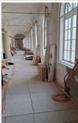
2.NP Opravy chodeb – levé křídlo
