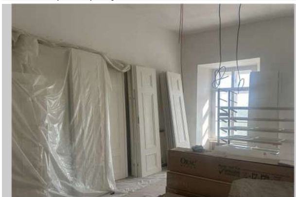
Probíhající renovace, opravy a nátěry historických interiérových dveří zdroj: vlastní a zadavatel
