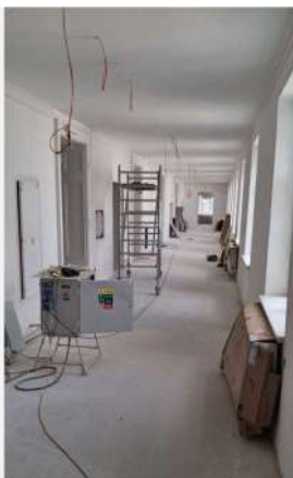
2.NP Opravy chodeb – levé křídlo
