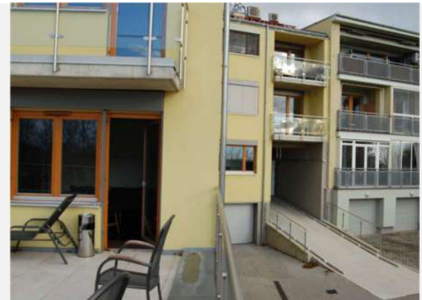
Pohled na terasu z východní strany
