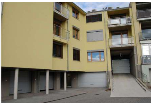
Pohled do dvora – vlevo garáže, napravo vjezd do dvorní části
