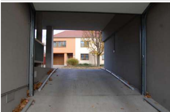
Pohled na výjezd na ulici Holzovu
