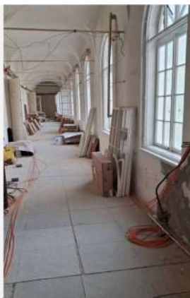
2.NP Opravy chodeb – levé křídlo
