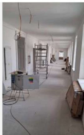
2.NP Opravy chodeb - střed
