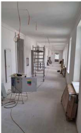
2.NP Opravy chodeb – levé křídlo
