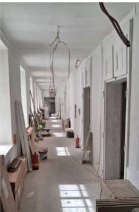
2.NP Opravy chodeb – pravé křídlo
