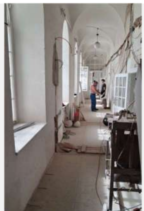
2.NP Opravy chodeb – pravé křídlo
