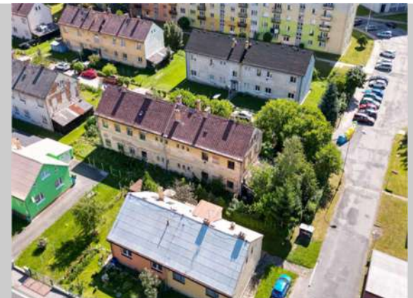
Pohled na bytový dům z východní strany
