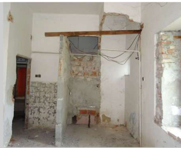
Bytová jednotka v 1.NP
