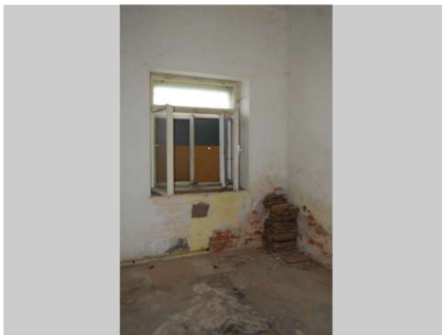
Bytová jednotka v 1.NP
