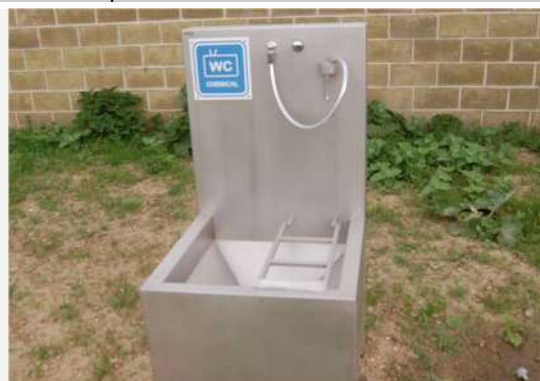
Pohled na likvidační zařízení fekálií
