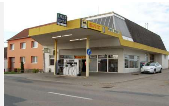
Pohled ze silnice III. třídy směr Moravská Nová Ves (ul. Nová/ Hlavní)
