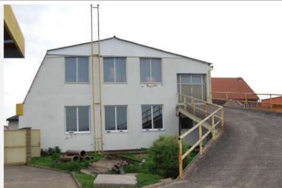
Pohled na vjezdovou rampu do podkroví
