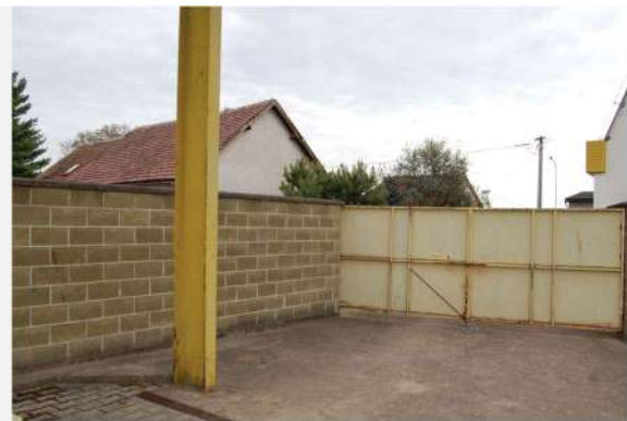
Vjezdová brána k uložišti nádrží z ul. Farní
