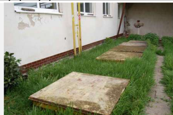
Stáčecí šachty na PHM
