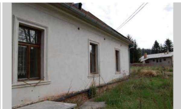
Pohled na mlýn z jižní strany
