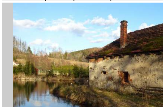
Vodní nádrž – pohled z jižní strany Zdroj: vlastní
