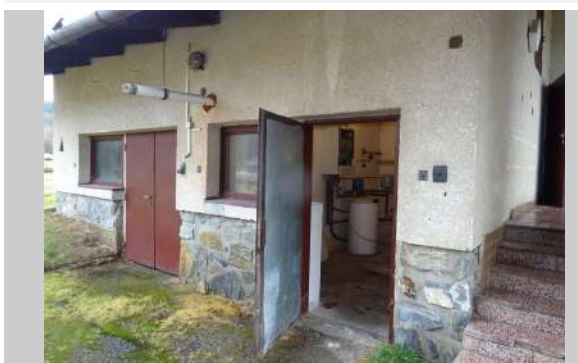
Sklad a technická místnost
